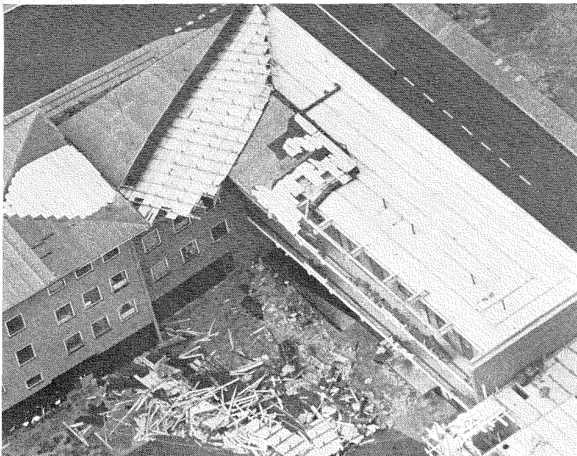
Fig. 1. Luftfoto af boligblokke med let tag på betondæk. Vinden var vinkelret på den mest skadede blok. Spærenes fastgørelse svigtede. (Thorkild Balslev foto).
